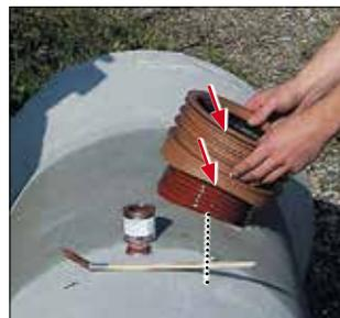
Bohrerschlussstutzen zentrisch mit Markierung in Achsenrichtung des Betonrohres bis zum Anschlag in die Bohrung eindrücken. Das zentrische Ansetzen ist wichtig, damit die erste Rippe der Gummimanschette gleichmäßig verpresst wird und nicht umschlägt.
