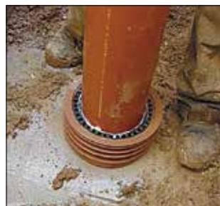
Vor der Montage der Anschlussleitung sind der Dichtring in der Muffe des Stutzens und die Rohrspitze der Anschlussleitung mit DS GV zu versehen. Bei einem abgeschnittenen Rohr muss die Spitze für die Montage angefast werden.
