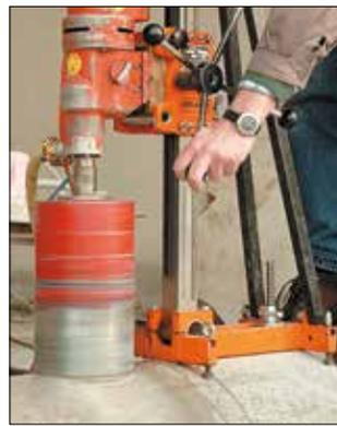
Kreisloch mit Diamant-Bohrkronen rechtwinklig und zentrisch zur Rohrachse bohren.
