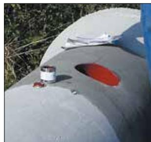
DS GV- Gleit- und Verankerungsanstrich - in der Blechdose mit beigefügtem Pinsel kurz durchrühren, dann auf der gesamten Gummimanschette dick auftragen. Auch die Bohrlochwandung einstreichen und das Material mit dem Pinsel kräftig in den Beton einreiben.
