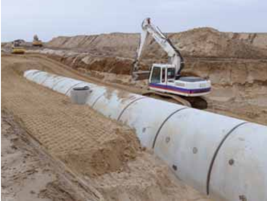
Abb. 3: Die Dichtungen wurden sowohl auf ihre Beständigkeit gegen die auf dem Flughafen eingesetzten Enteisungsmittel als auch gegen Kerosin geprüft
