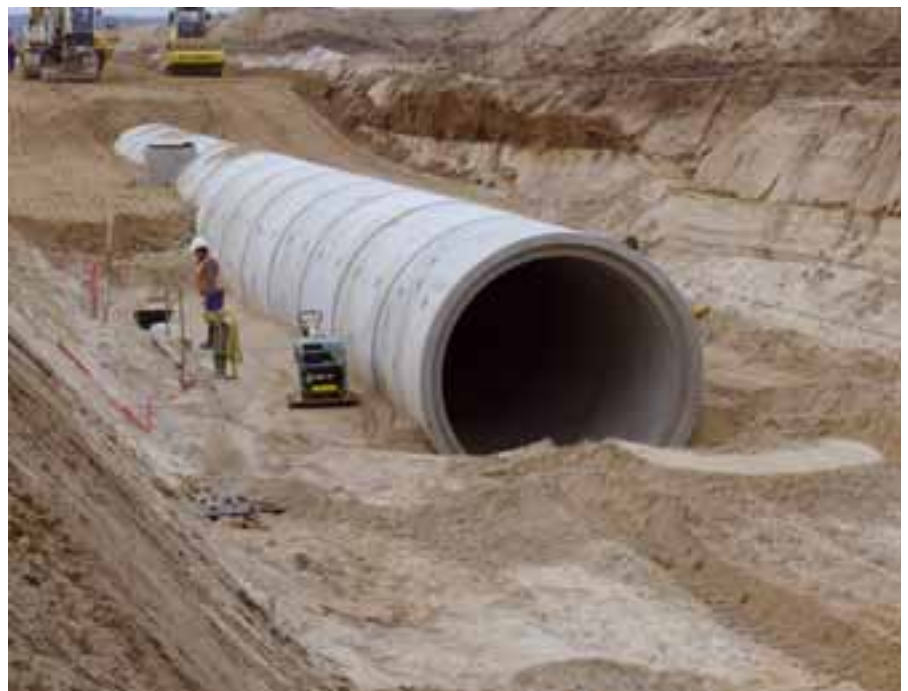
Abb. 2: Insgesamt werden 22 km Entwässerungskanäle verlegt und 400 Schachtbauwerke aus Betonfertigteilen errichtet
